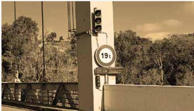
Des feux tricolores viennent d'être mis en service sur le pont de Bessières par le département. Ils assureront la gestion des flux de véhicules (présence d'un seul poids lourd à la fois sur le pont suspendu).
