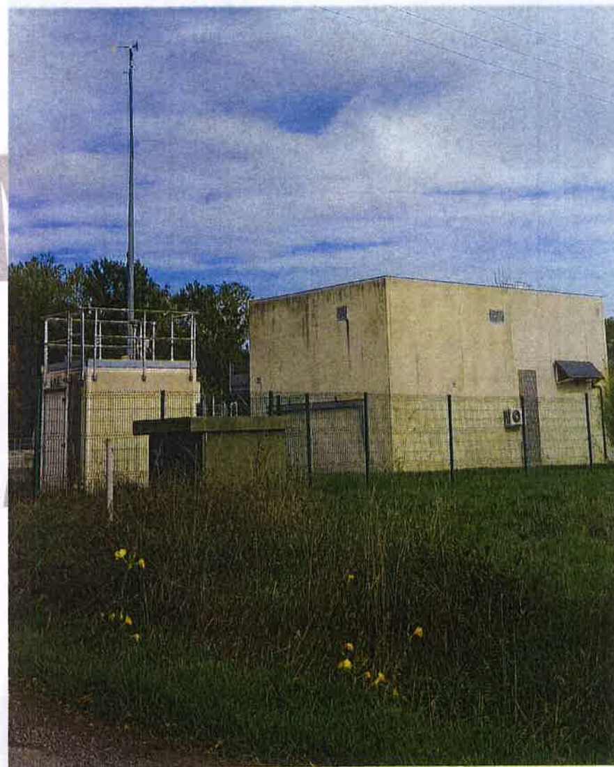
Station d'épuration /// © Karthéo 2022
